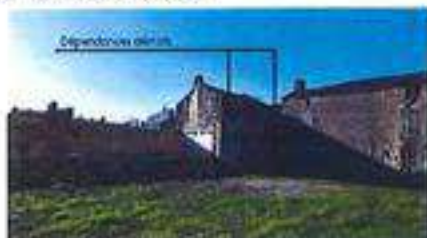
PHOTO 2 : Vue depuis l'Est de la parcelle
