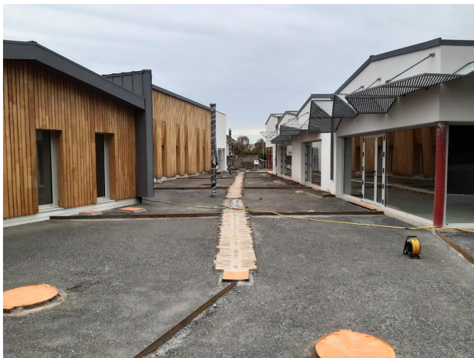
Vue générale côté escalier
