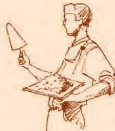
▲ enduit déposé et lissé à la truelle.
