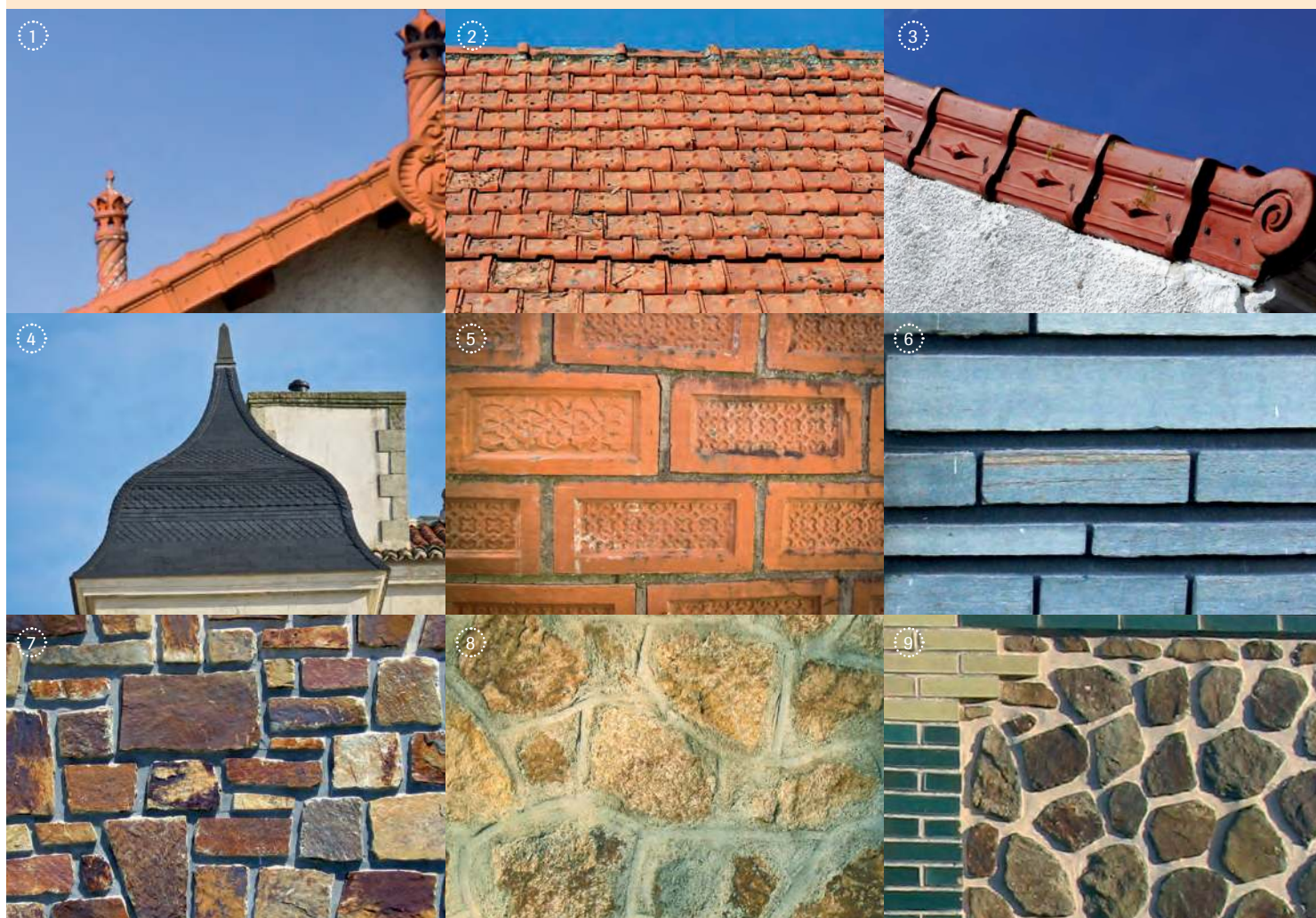
1, 2 & 3: Tuiles mécaniques décorées. / 4: Ardoises. / 5: Briques décorées. / 6 & 7: faux parements de pierre. 8: pierres posées à pierre vue. / 9: parement de pierre et briques vernissées.
