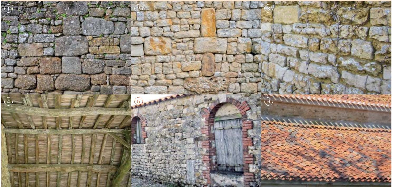
1, 2 & 3: Murs en pierre locale. / 4: Charpente en bois sur une grange en pierre calcaire. / 5: Encadrement en tuile et mur en calcaire. / 6: Toiture en tuiles canal et corniche en calcaire.
