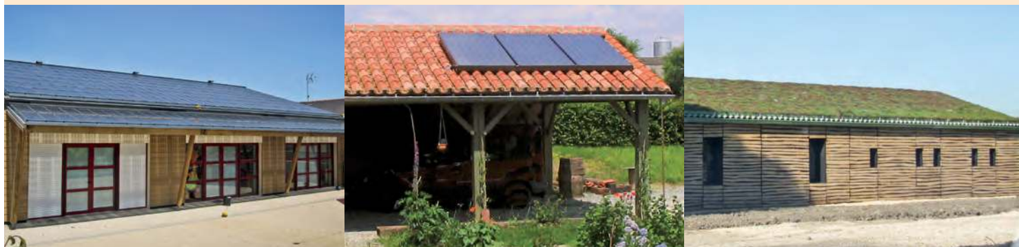
1 : Exemple de toiture intégrant des panneaux solaires photovoltaïques. / 2 : panneaux solaires thermiques. / 3 : exemple de toiture végétalisée.
