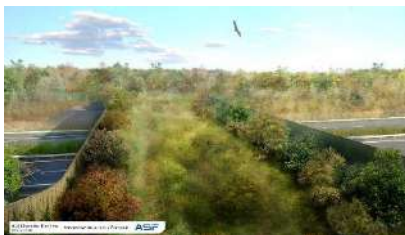
Exemple 2 : Ecopont au-dessus de l'A10
