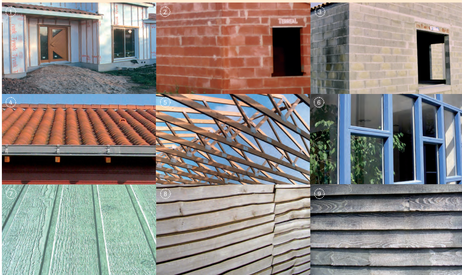
1 : Maison à ossature bois. / 2 : Brique creuse. / 3 : parpaings de béton. / 4 : tuile canal. / 5 : charpente fermette. / 6 : verrière. 7, 8 & 9 : échantillons d'essences de bois rencontrées en Sud Vendée.
