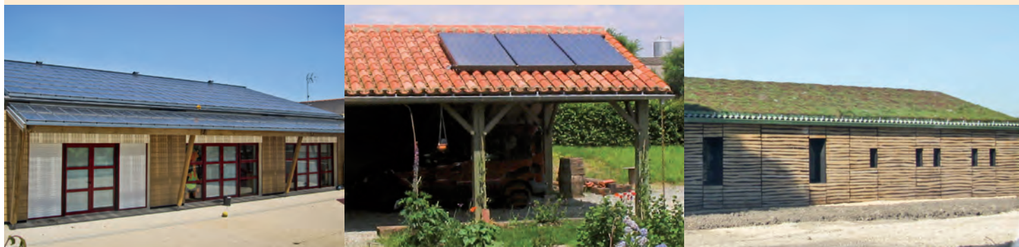
1 : Exemple de toiture intégrant des panneaux solaires photovoltaïques. / 2 : panneaux solaires thermiques. / 3 : exemple de toiture végétalisée.
