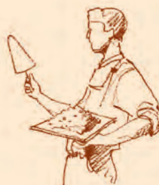
▲ enduit déposé et lissé à la truelle.
