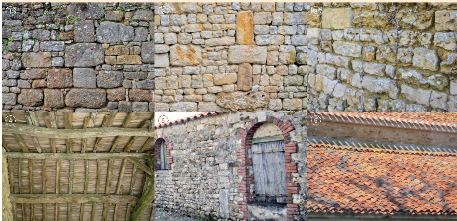
1, 2 & 3: Murs en pierre locale. / 4: Charpente en bois sur une grange en pierre calcaire. / 5: Encadrement en tuile et mur en calcaire. / 6: Toiture en tuiles canal et corniche en calcaire.
