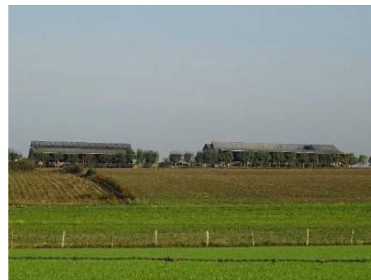
Bâtiments agricoles intégrés grâce à un alignement d'arbres
