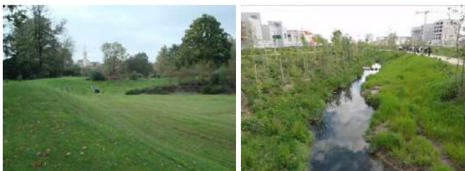
Exemple de bassin ou noues de récupération des eaux pluviales aménagés en espaces de convivialité
