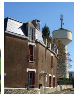
Château d'eau de La Châtaigneraie
