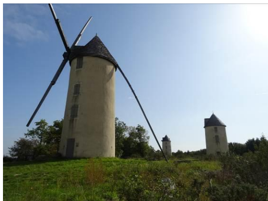
Moulins sur la colline des moulins à Mouilleron-Saint-Germain
