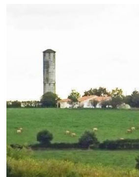
Château d'eau de Cheffois
