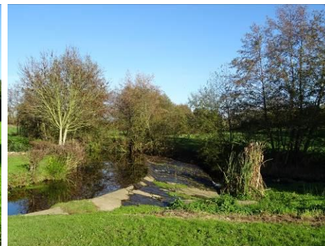
Aménagement sur la rivière lié à un ancien moulin - Le Moulin de Chollet, Antigny
