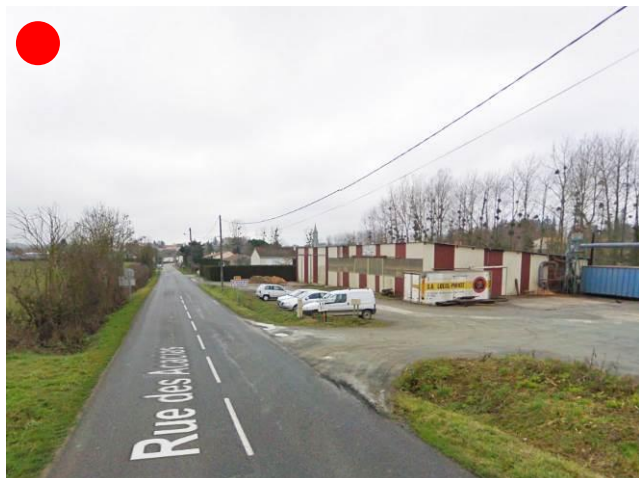
Entrée de ville "dégradée" : lisière de la zone économique non végétalisée et abords non aménagés - Google Street View
