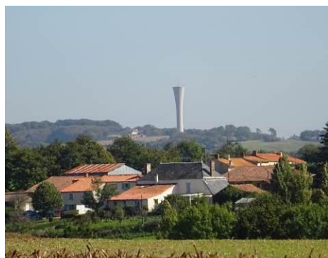
Château d'eau à Beauvoir, commune déléguée de Breuil-Barret
