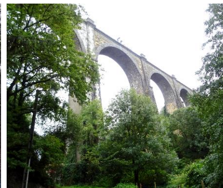
Viaduc du Coquilleau au-dessus de la Mère offrant une activité de saut à l'élastique - Limite entre les communes de Terval (communes déléguées de Breuil-Barret et de La Tardière) et de La Châtaigneraie
