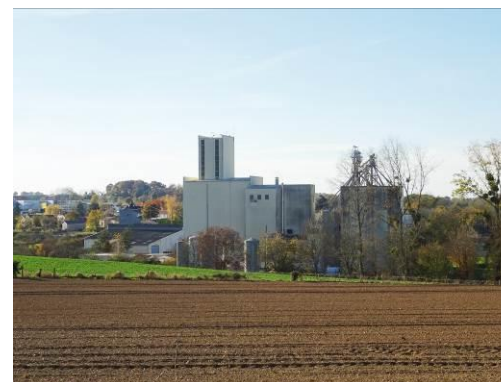
Usine industrialo-agricole du Moulin Gendoux à Antigny
