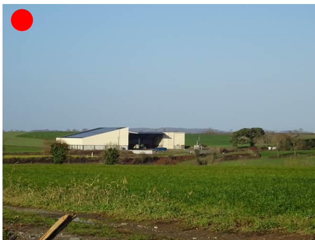
Bâtiment agricole non intégré au paysage à cause de son importante hauteur, de sa couleur particulièrement visible et de l'absence de végétation en frange et aux alentours
