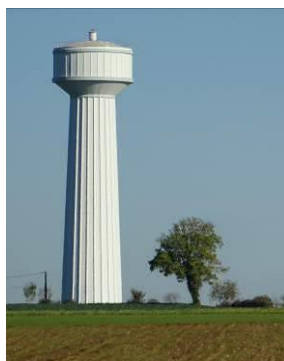
Château d'eau à rainures de Bazoges-en-Pareds
