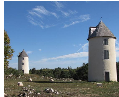
Moulins à vent de Mouilleron Saint Germain
